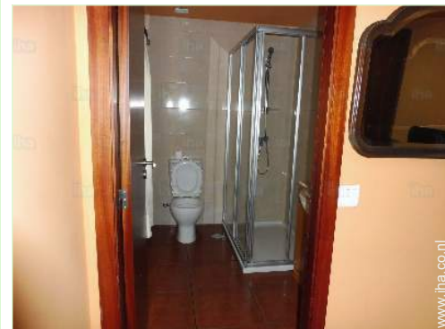
Badkamer(s) met bad
