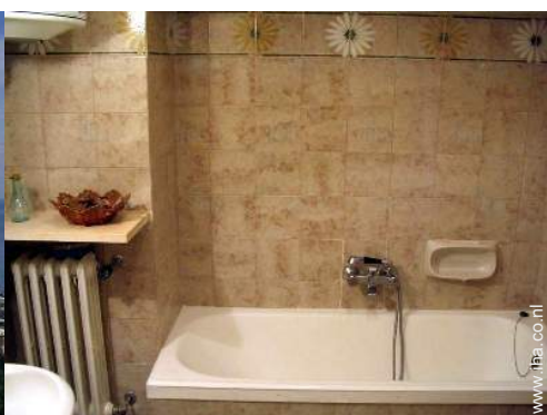
Badkamer(s) met bad
