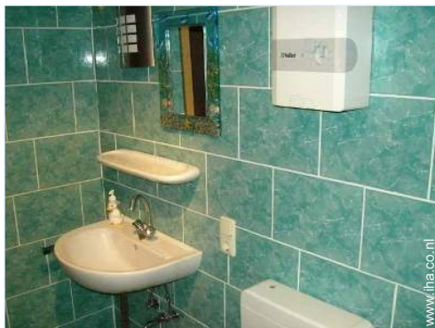
Badkamer(s) met bad
